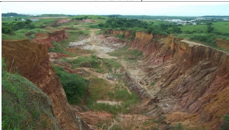
FOTOS 6.2.3.7.1-2: Instabilidade das encostas na área da antiga cava de saibro (UTM 204218/7520468)
