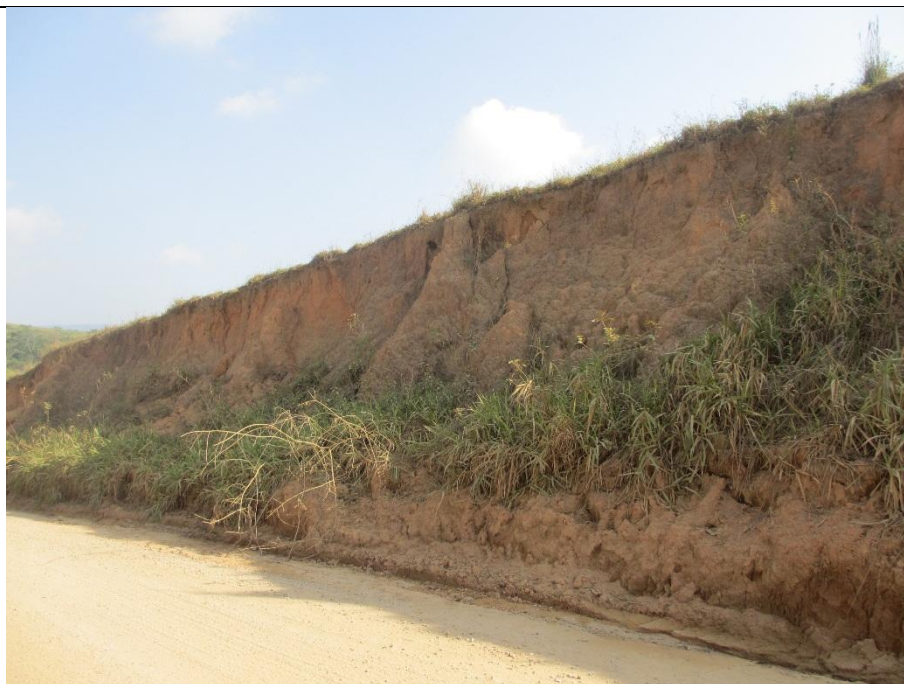
FOTOS 6.2.3.7.1-1: Sulcos erosivos nas margens da estrada de acesso da ADA (UTM 204725/7519514)
