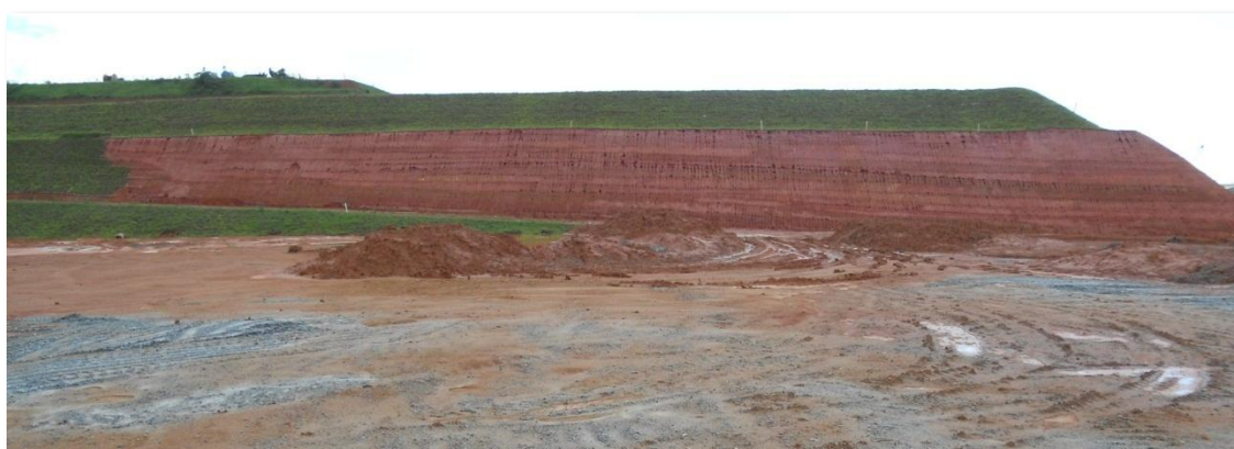
FOTO 6.2.3.4.2-1: Terraplenagem na área do empreendimento, em primeiro plano observa-se o nivelamento topográfico mais baixo e em segundo plano o terreno em cota mais elevada também objeto de terraplenagem.
