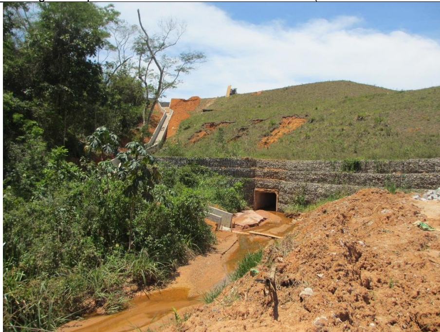
FOTOS 6.2.3.7.1-6: Córrego localizado na porção central da ADA. É possível verificar as obras de drenagem e o aterro executado na área. Na margem direita do rio não há vegetação e ocorre acúmulo de material com carreamento para o córrego. (UTM 203942/7519167).
