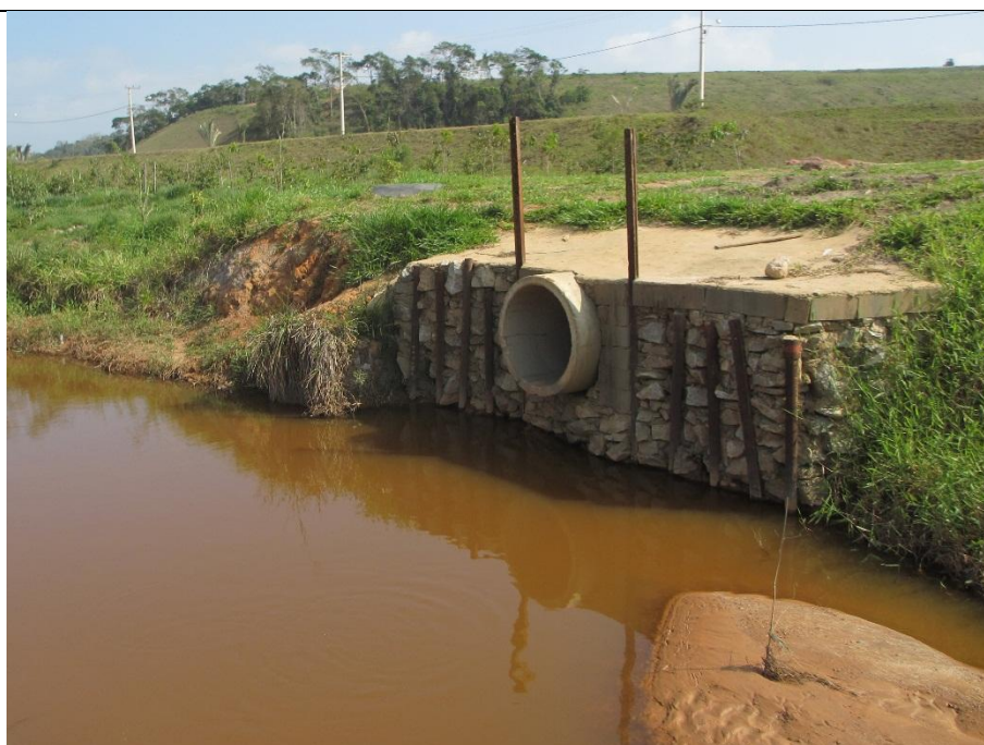
FOTOS 6.2.3.7.1-4: Sistema de drenagem executado próximo à AID do projeto (rio Imboassica) com erosão na margem e banco de areia no centro do córrego. (UTM 202340/7518605)
