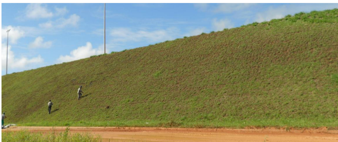
FOTO 6.2.3.4.2-2: Aterro executado com o talude já apresentando cobertura de gramínea
